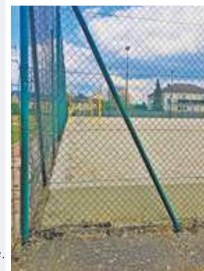
Amnéville, Moselle Bordures réalisées en béton
